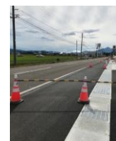
上越安塚柿崎線路肩拡幅工事
