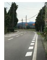
県道新井柿崎線（三和区下中地内）
